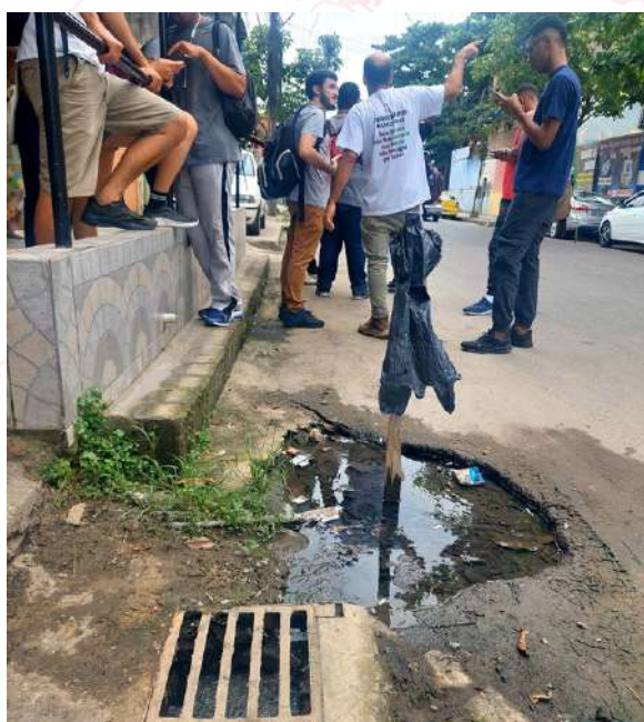
Observação em grupo da drenagem pluvial em rua do bairro Paraíso
